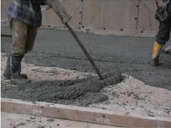
Formazione di una cappa in calcestruzzo avente lo stesso RcK della successiva platea, per uno spessore  $\geq 5$ cm quale protezione del sistema impermeabilizzante. Tale cappa potrà essere omessa su indicazione della D.L. Ogni onere e fornitura compresa
